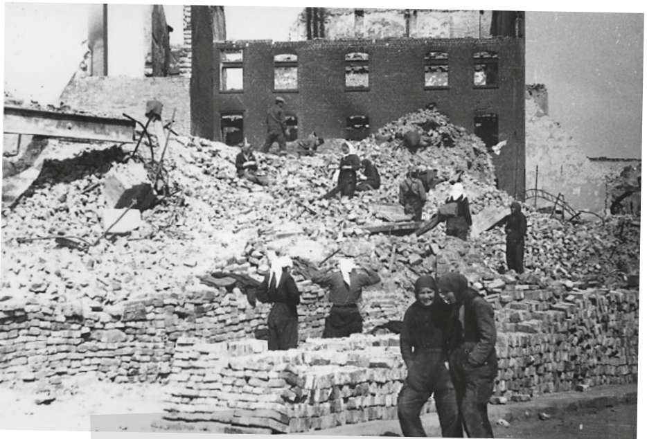
Zerstörung durch den Bombenangriff an der Kasseler Schomburgstraße mit Ukrainischen Trümmerfrauen
